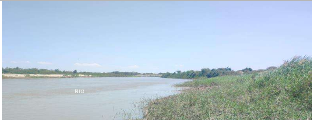
FIGURA N°01: TRAMO CRÍTICO EN EL RIO PIURA, EN SECTOR SECTOR NUEVO SINCHAO CHICO - NUEVO TALLAN - EL TABANCO, DISTRITO TALLAN, PROVINCIA DE PIURA - PIURA.
